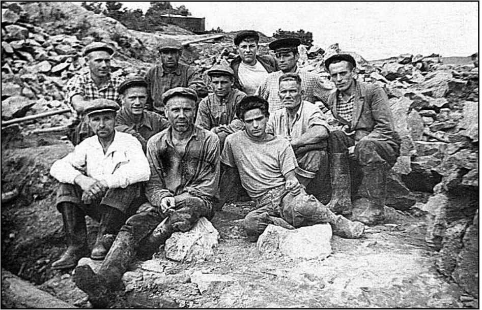
На будівництві мосту.
